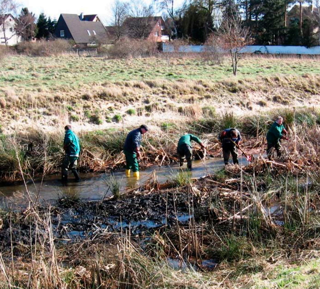
Unterhaltungsarbeiten am Galgengraben in Hannover-Vahrenheide
